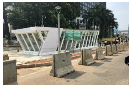
【建設中の地下鉄駅入口:筆者撮影】
