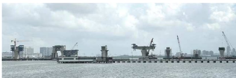
【建設中の新規高速鉄道(事務所撮影)】
